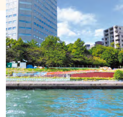
工事中のスロープ
